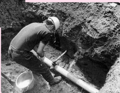
漏水修繕工事▶
