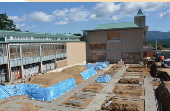
藤原小学校新築工事
