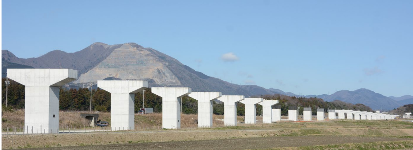
東海環状自動車道の橋梁
