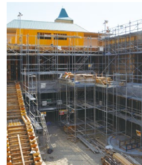
建設中の藤原小学校
