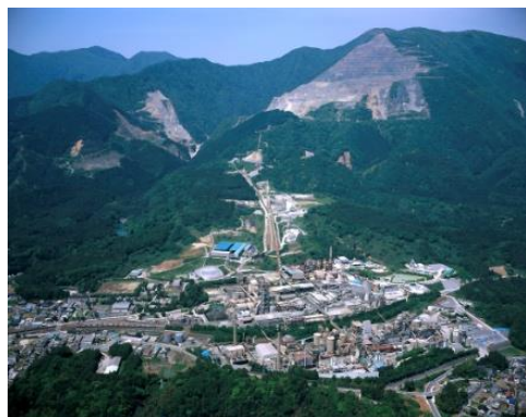
太平洋セメント株式会社 藤原工場
