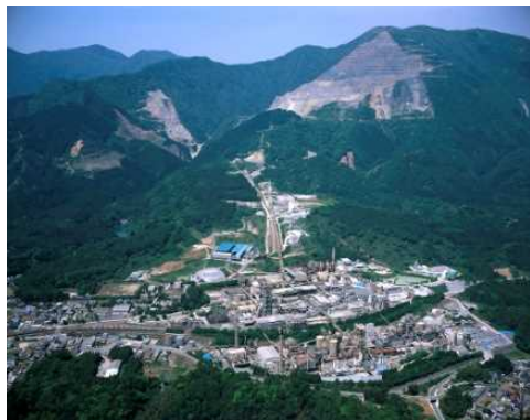
太平洋セメント株式会社 藤原工場
