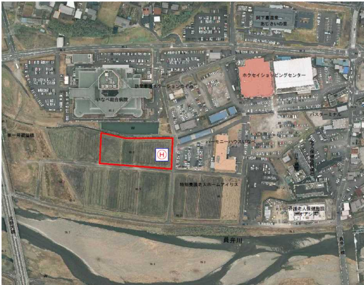
【現在、建設中のヘリポート】
