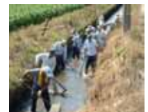
水路の泥上げ
