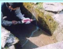
水路のひび割れ補修
