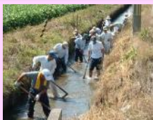
水路の泥上げ
