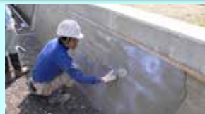
老朽化した水路壁のコーティング
