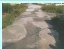
農道の窪みの補修
