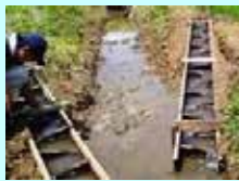
水田魚道の設置
