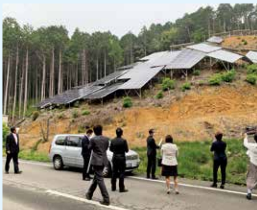
太陽光発電所を現地調査
