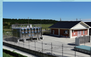
北勢町麻生田水源地（効率的な水道利用のため、平成 28 年度から運用）
