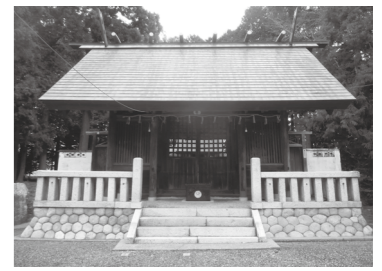
【拝殿正面の写真】
