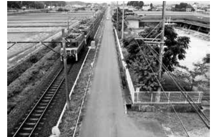
市道江丸線（大安町門前・大井田地内）
