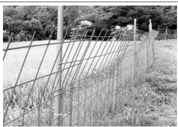
イノシシの視線(70cm)から柵より50cm離れて見上げると約20cm高く感じるのが30度の折り返し
