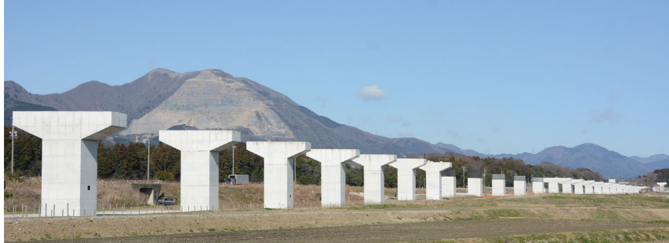
東海環状自動車道の橋梁
