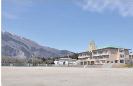
藤原中学校の敷地内に小学校を建設。
