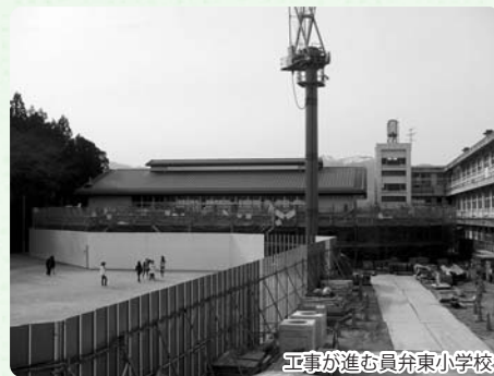
工事が進む員弁東小学校
