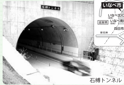
石榑トンネル
