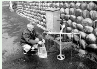
▲消火栓に装着し給水できる臨時給水栓
